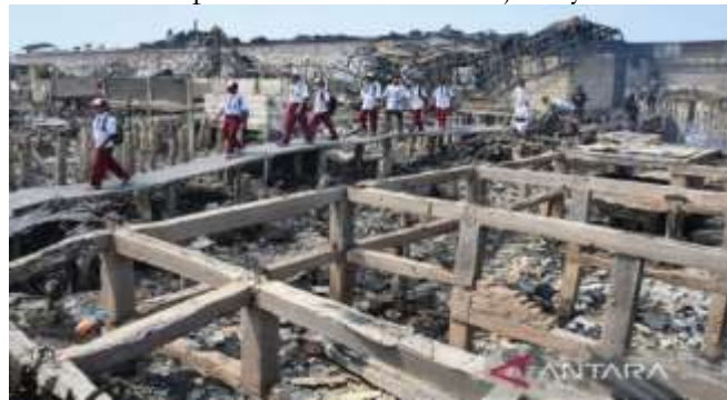
Gambar 1. Kondisi pemukiman setelah terjadinya kebakaran
