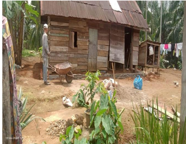
Gambar 1. Rumah yang tidak layak mendapatkan bantuan bedah rumah
