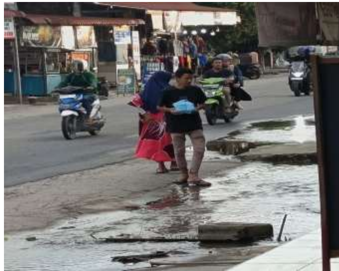
Gambar 3. Genangan Air di Selokan Akibat Penyumbatan Sampah
